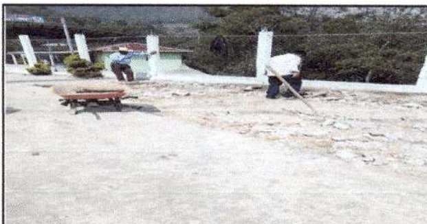
Foto 6: preparación para fundición losa de patio
