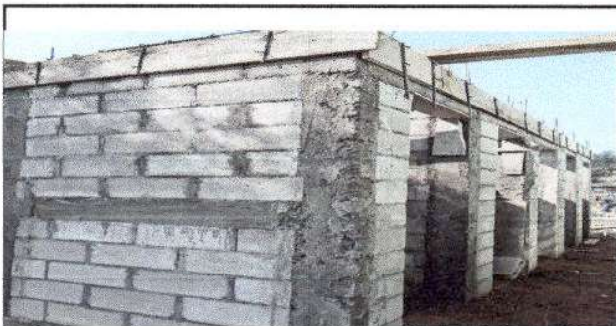
Foto 5: trabajo para reconstrucción de estructura de servicio sanitario
