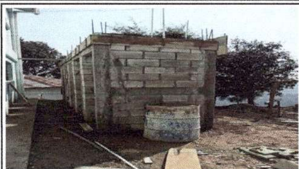
Foto 1: reconstrucción reparación de losa
