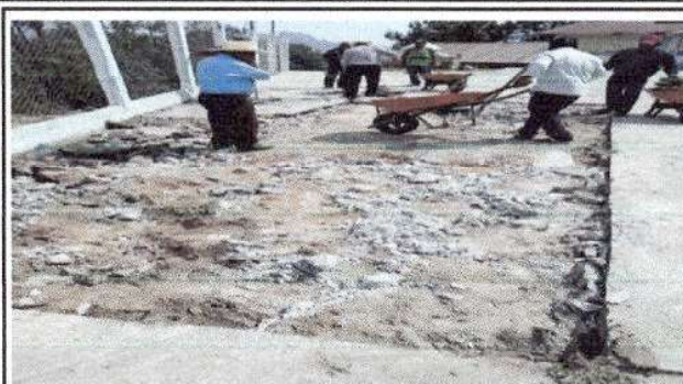
Foto 2: preparación para fundición losa de patio
