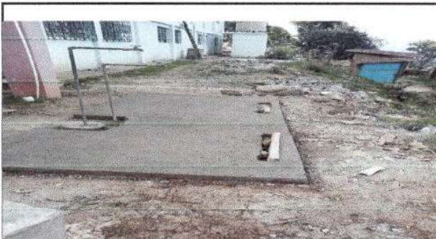
Foto 3: construcción de plancha para ubicación de pila
